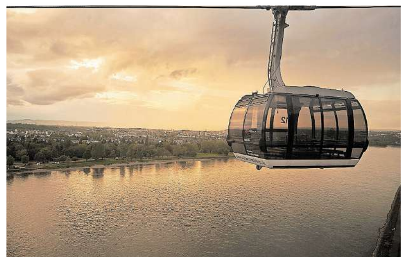
Für Städte eine Alternative: Seilbahnsysteme wie am Deutschen Eck in Koblenz. Moderne Kabinen können bis zu 35 Personen befördern.
